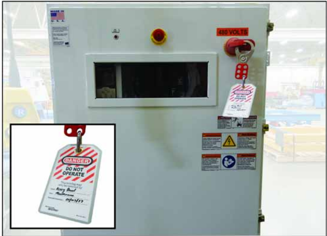
Figura SEGURIDAD-1: Mecanismo de bloqueo/etiquetado en un gabinete eléctrico principal
