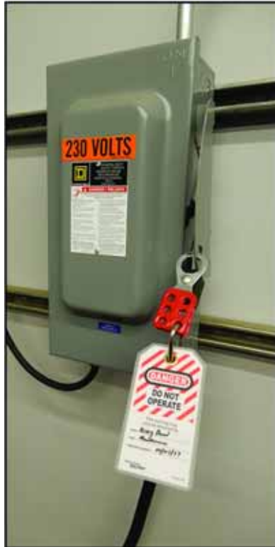
Figura SEGURIDAD-2: Ejemplo de un mecanismo de Bloqueo/Etiquetado en un panel de entrada de suministro eléctrico
